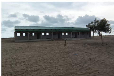
Bloco de 4 salas de aula
